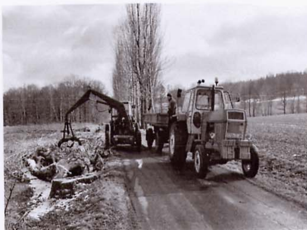
Fäll- und Beräumungsarbeiten an der Steinbergstraße
