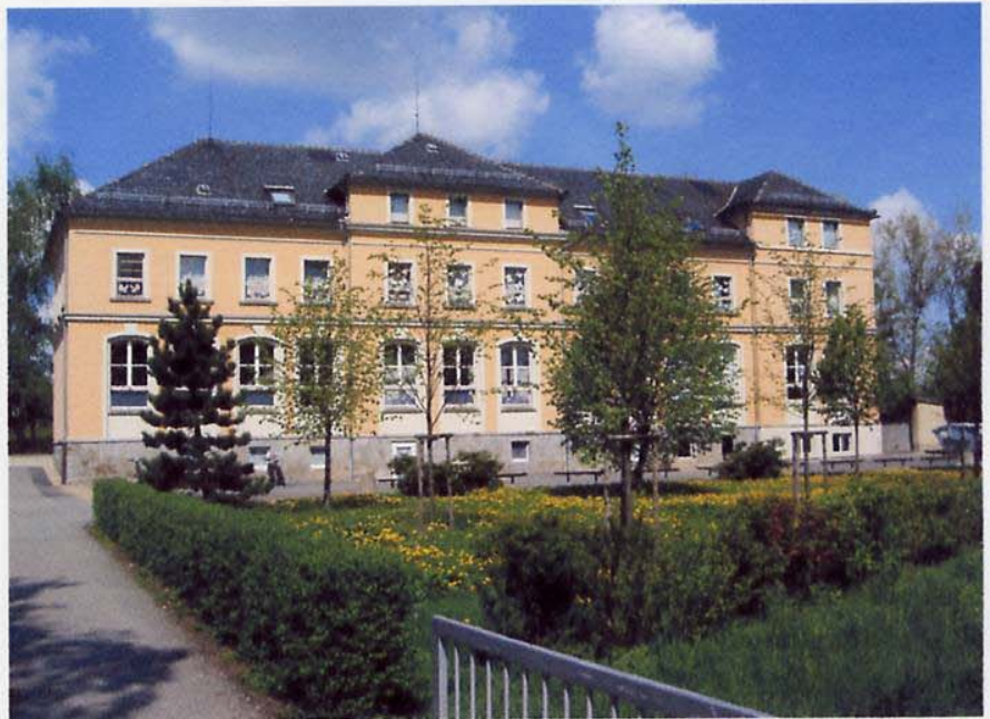
Schule im Ortsteil Herwigsdorf
