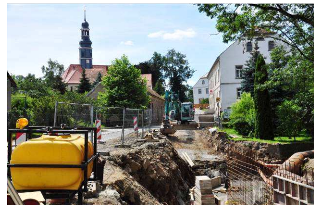
Erneuerung Stützmauer mit Fußweg am Mittelhofweg
