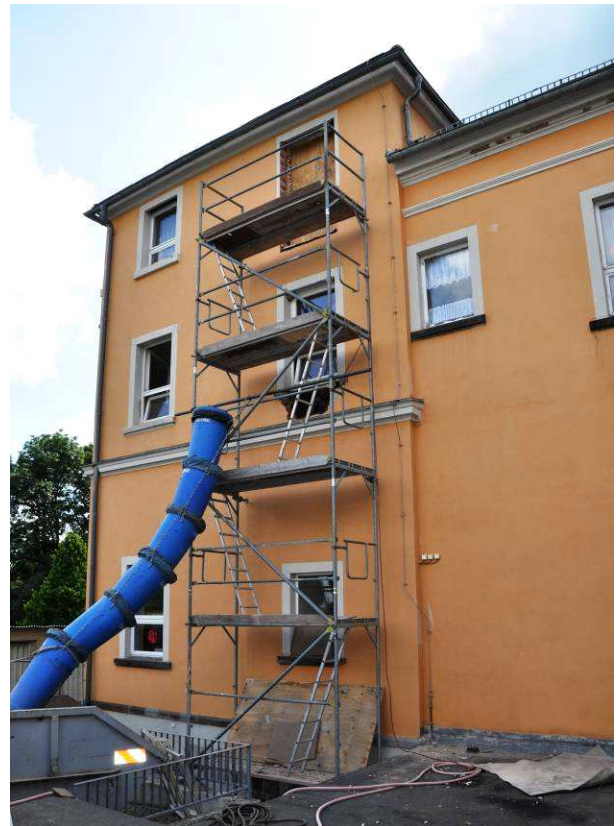
Anbau Treppe und Brandschutz an der Grundschule
