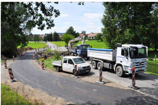
Neubau Brücke BW 8 im OT Bischdorf
