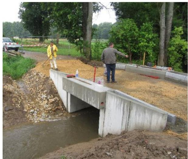
Die Natursteinbrücke wurde durch das Hochwasser 2013 stark geschädigt. Die Widerlager und Flügelmauern waren so defekt, dass die Standsicherheit und damit die Verkehrssicherheit beeinträchtigt waren. Eine Sanierung ist auf Grund des Schadensbildes nicht mehr möglich. Die neue Brücke wurde als Fertigteilrahmen in Stahlbetonbauweise errichtet. Die lichte Weite beträgt 2,00 m, die lichte Höhe 1,75 m. Es sind Gesamtkosten von 64.000 € veranschlagt. Die Fertigstellung ist für den 05. August geplant.
