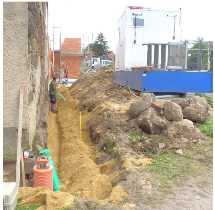
Drän- und Regenwasserleitungen wurden um das gesamte Gebäude verlegt
