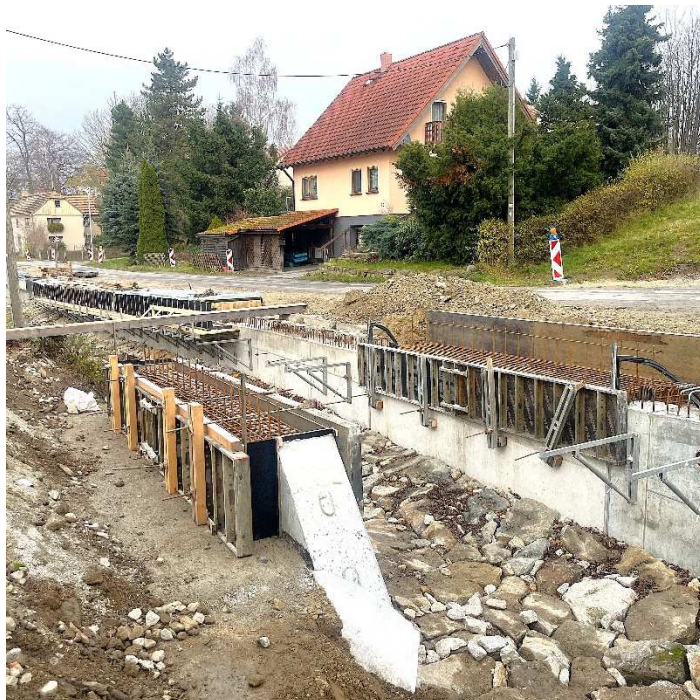
Fundamente der neuen Brücke
