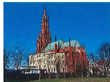
Dreifaltigkeitskirche Lauban Foto: Gunther Tschuch (Wikipedia)
